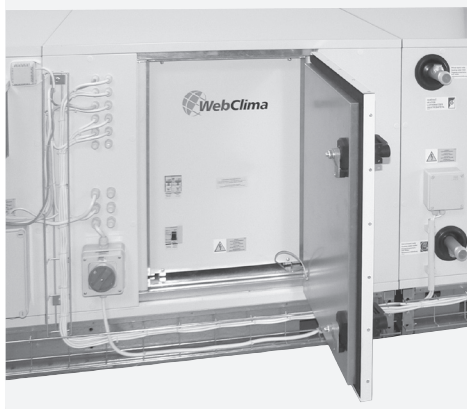
Рис. 2 – монтаж в секции установки XP
