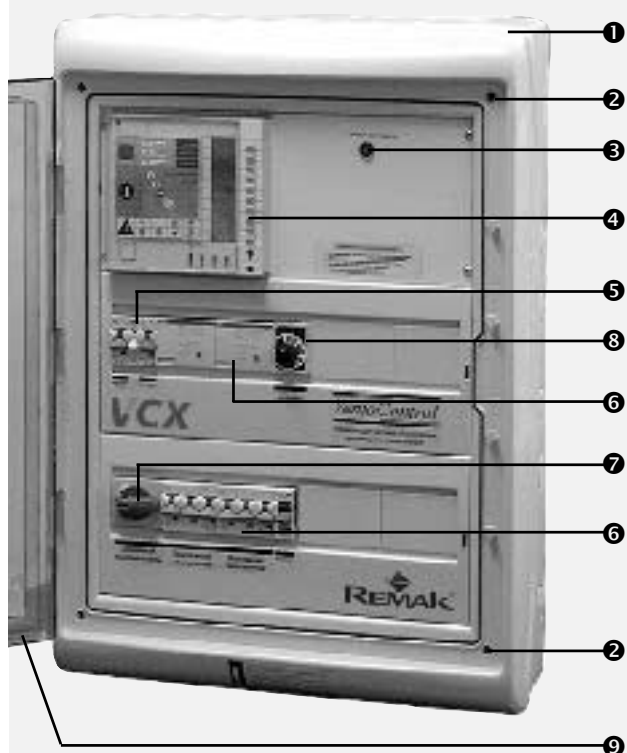
Рис. 4 – конструкция блока VCX
